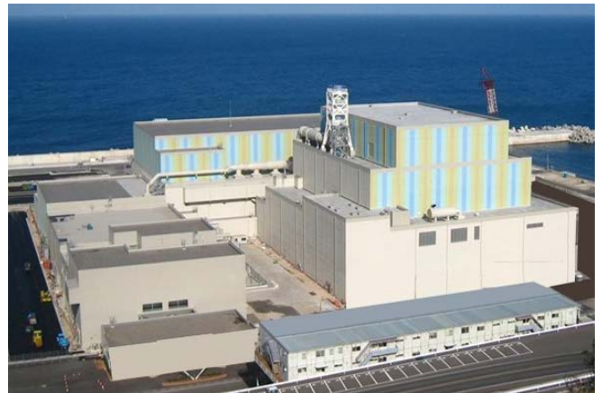
中国電力(株) 島根原子力発電所3号機(建設中)
