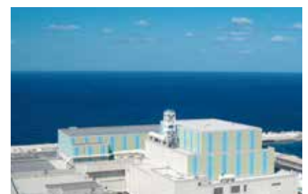
中国電力株式会社 島根原子力発電所3号機(建設中)
