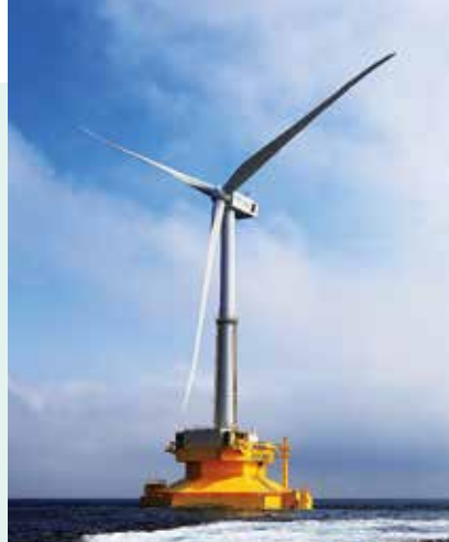
5MW浮体式洋上風力発電設備(提供:福島洋上風力コンソーシアム)
